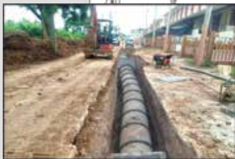
งานวางท่อคสล.และบ่อฟัก
