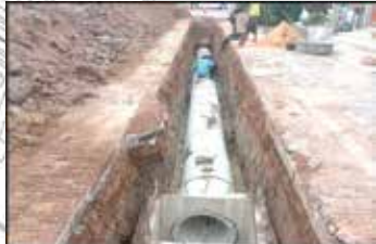
งานวางท่อคสล.และบ่อบัฟ
