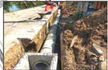
งานวางท่อคสล.และบ่อพัก
