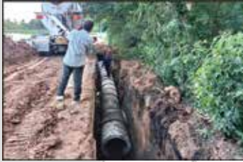
งานวางท่อคสล.และบ่อพัก
