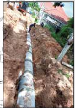
งานวางท่อคสล.และบ่อพัก
